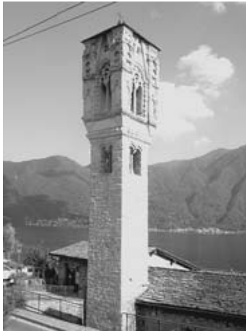
Ossuccio (CO), il celebre campanile romanico della chiesa di Santa Maria Maddalena fu sopraelevato tra XIV e XV secolo con la costruzione di una cella campanaria in cotto.
