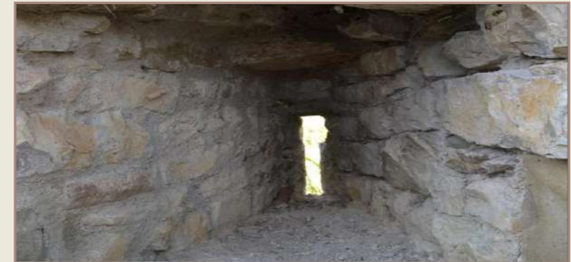
Arciera - fessura verticale ricavata nella mura per poter bersagliare gli assalitori senza esporsi mediante l'utilizzo dell'arco
