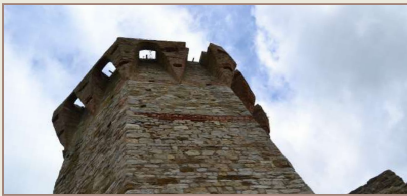
Piombatoia - apertura negli elementi a sporgere in cima alla cortina da cui era possibile gettare proiettili, pietre e altri materiali sugli assalitori
