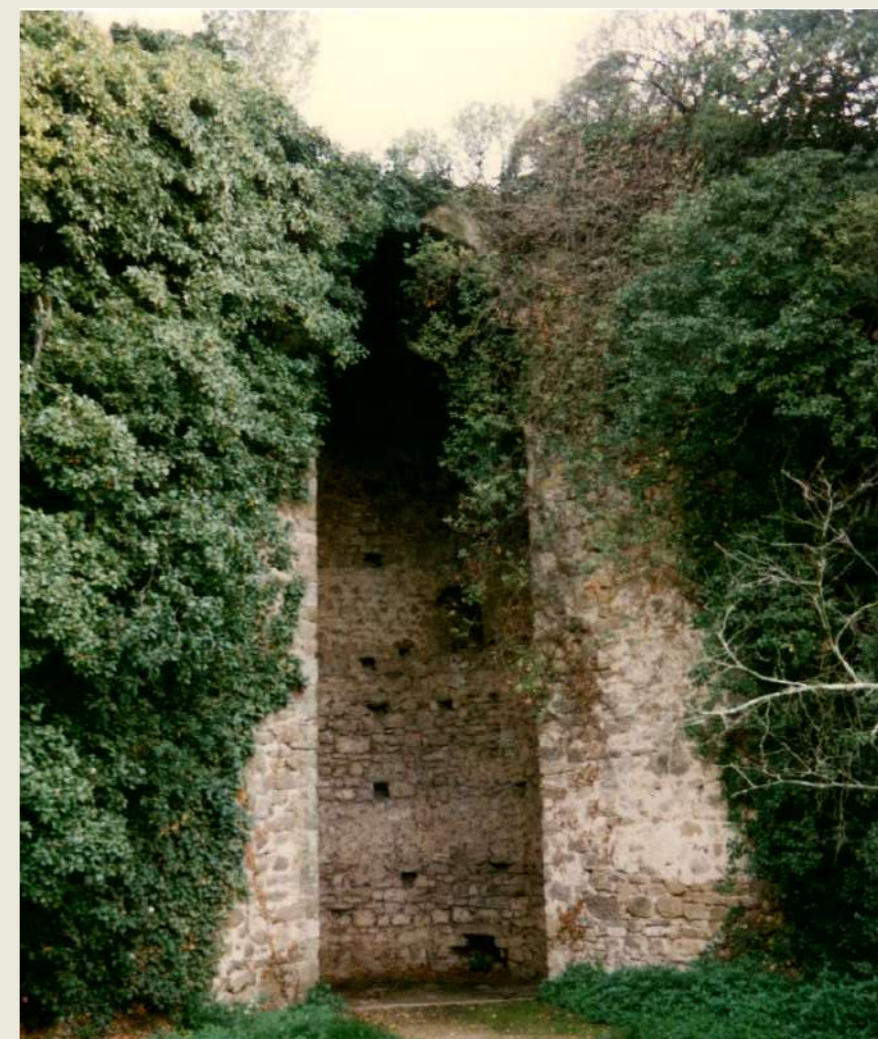
Fotografia prima degli interventi del 2000, torre.
