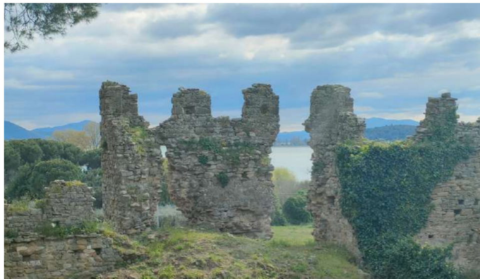
Lato sud est della cinta muraria
