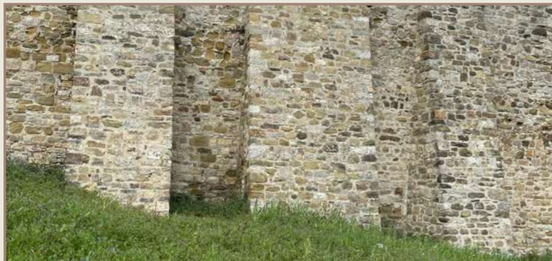
Contrafforti - sostegno pieno a sezione quadrangolare collocato in determinati punti della muratura con funzione di rinforzo e contropinta
