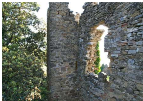
Lato est della cinta muraria
