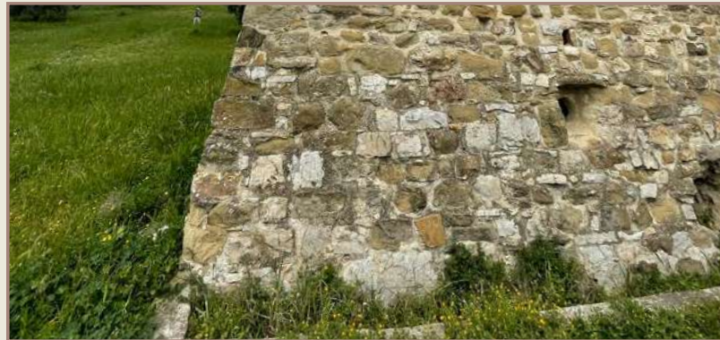
Scarpa - parte della cinta muraria nella quale la parete, anzichè verticale, è pbligua, con funzione di rafforzamento e annullamento degli angoli morti
