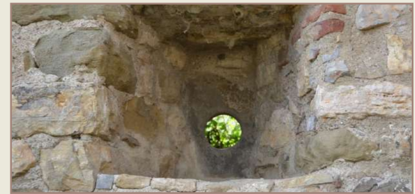
Archibugiera - fessura circolare ricavata nella mura per poter bersagliare gli assalitori senza esporsi mediante l'utilizzo dell'archibugio
